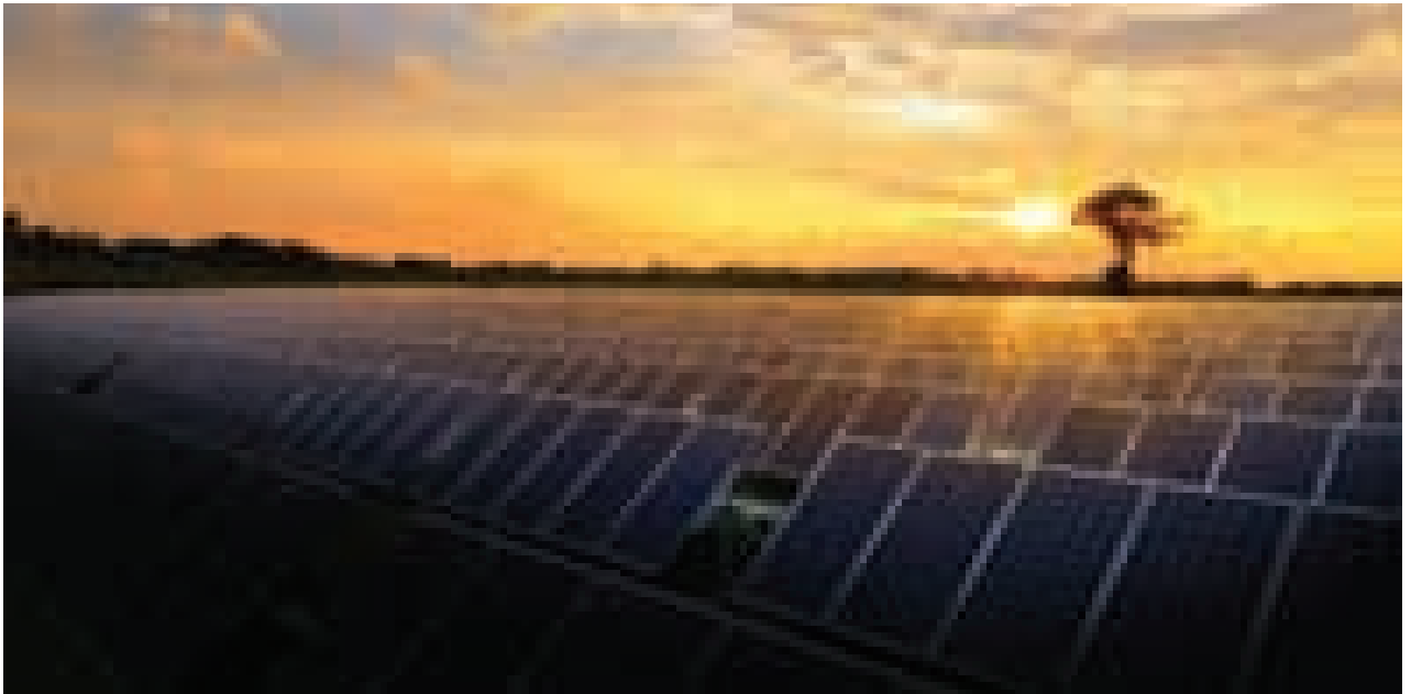
Şekil 7. Fotovoltaik enerji santrali
