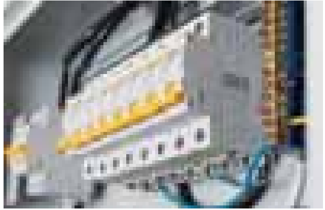
Şekil 2. Sigortalar – evlerde kısa devre meydana geldiğinde elektrik akımını otomatik olarak kesen devre kesiciler.
