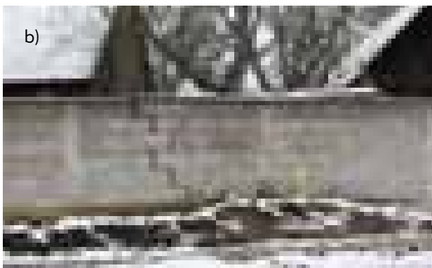
Figura 4. (a) Dëmtimi i rrugës së asfaltuar kur uji përhapet dhe e ngrin atë. b) Gardh betoni i dëmtuar për shkak të përhapjes së ujit
