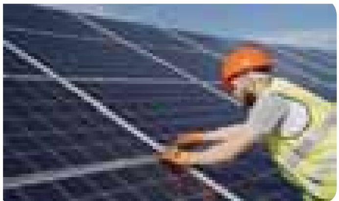
Foto 3. Panelet diellore për marrjen e energjisë elektrike nga rrezet e diellit.
