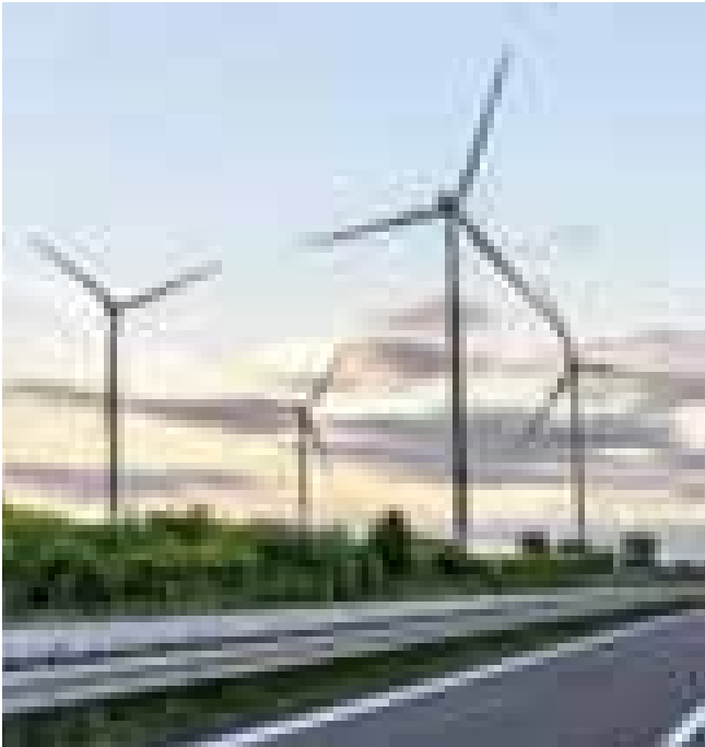
Foto 1. Energjia kinetike e erës shtyn tehet e turbinës së erës
