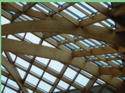
Konstruksioni i kulmit nga druri prej lamele
