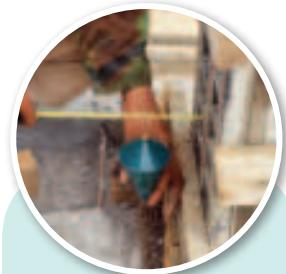
Određivanje vertikalnog pravca zida sa viskom
